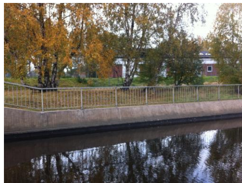
Figur 9 Gullbergsån idag i anslutning till kulvert.
