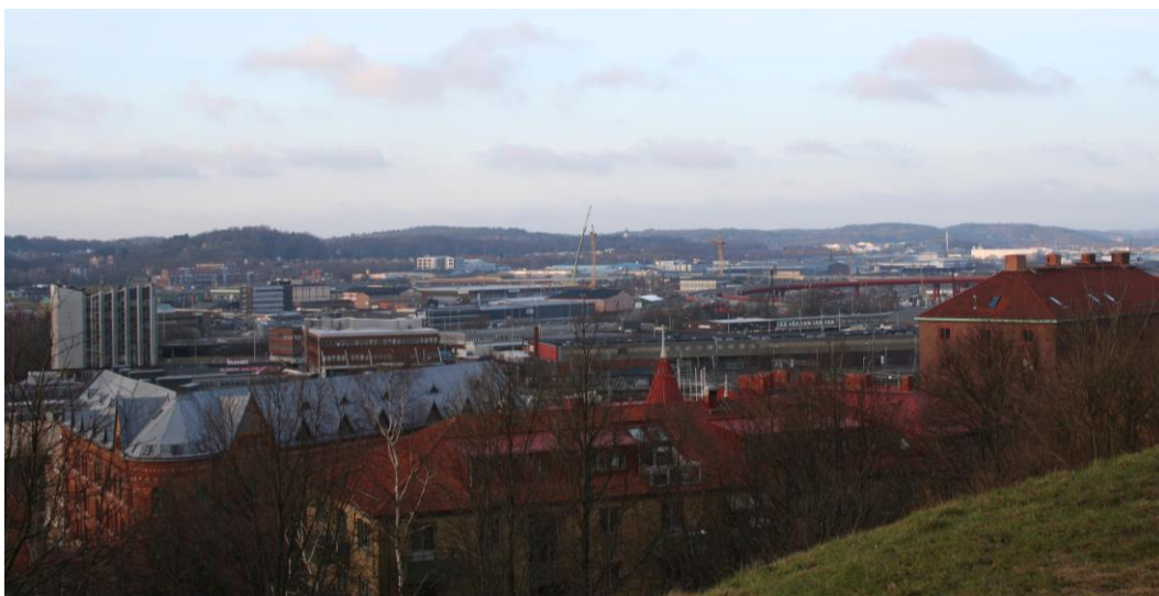
Figur 2 Vy över del av planområdet från Redbergsparken. Området präglas av väg- och järnvägsinfrastruktur samt industribyggnader.
