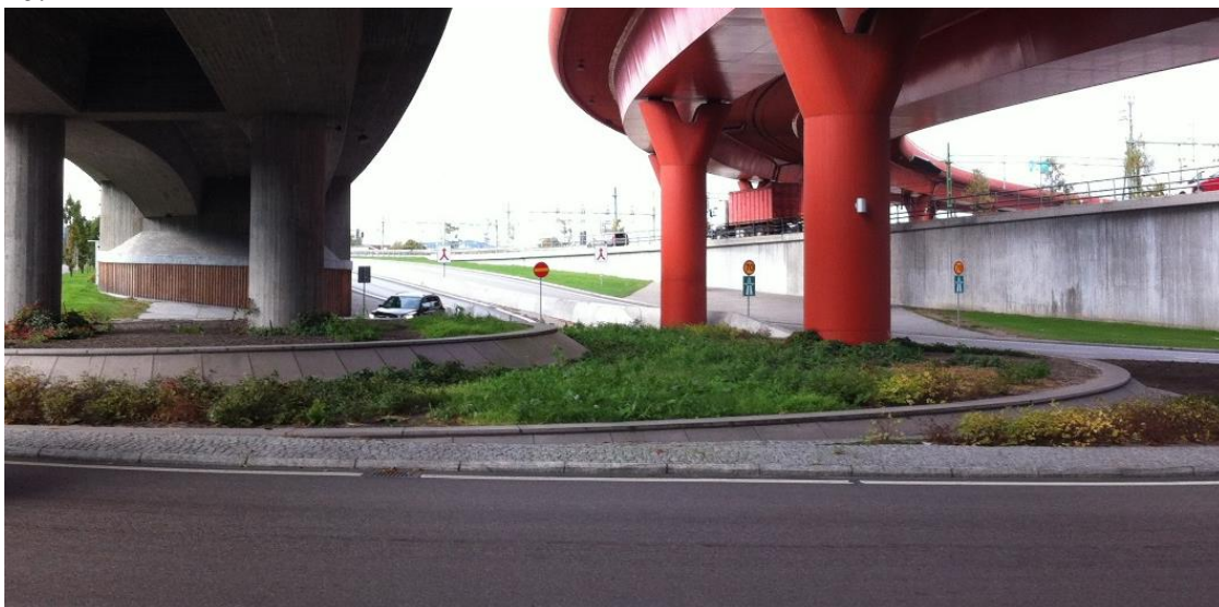
Figur 6 Exempel på hur omsorg tagits till mellanrummen under Röde Orm. Planteringar med låg vegetation och klippta gräsytor. Betongytorna är klädda med träribbor, ett klotterskydd som även har ett gestaltungs-mässigt egenvärde.
