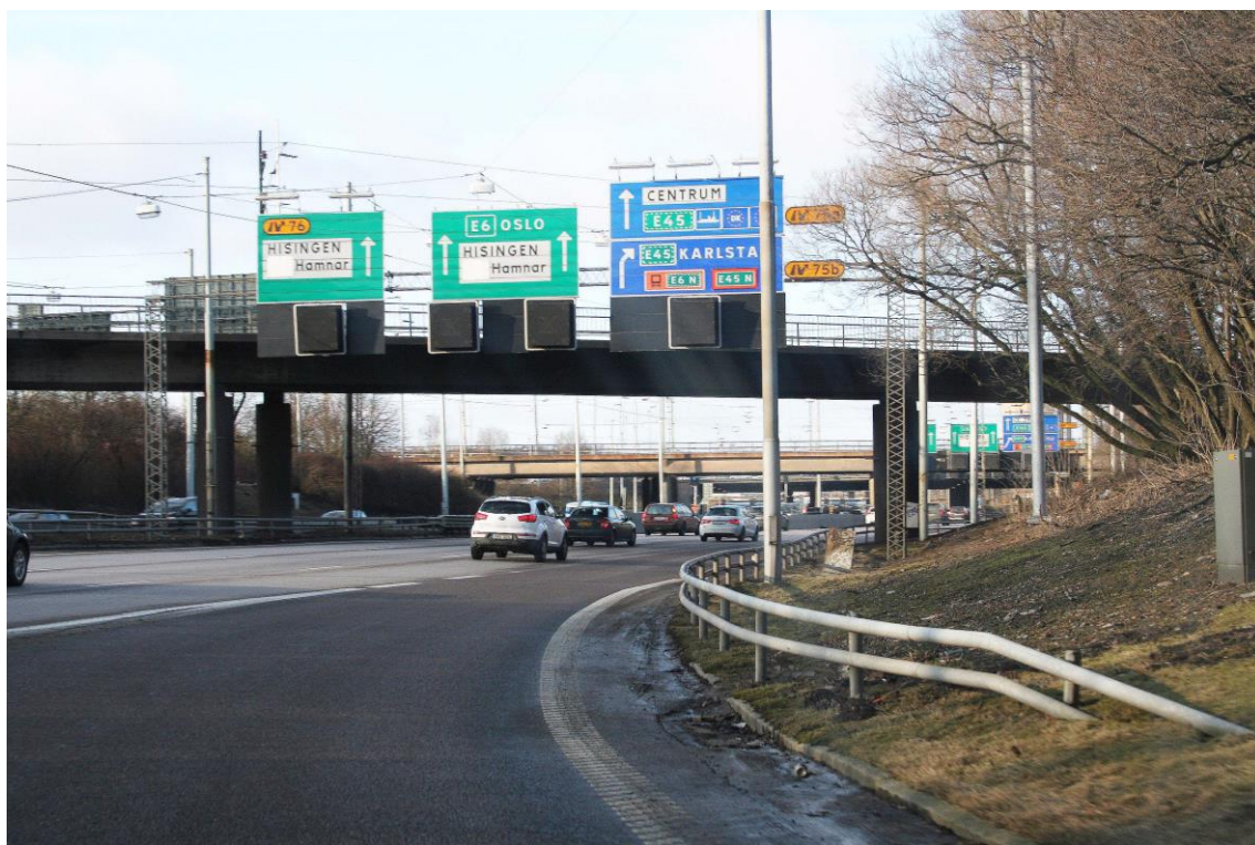
Figur 7 befintliga broar över E6 vid Olskroken är alla låga broar med stöd i mitten av E6.
