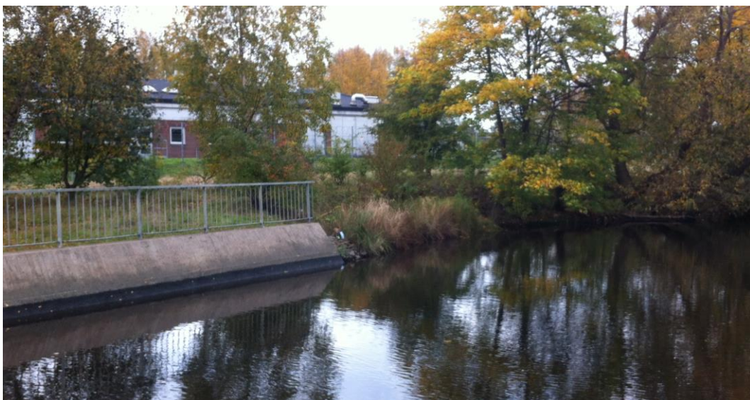
Figur 10 Gullbergsån idag, övergången mellan betongkanter och släntad åbrink.
